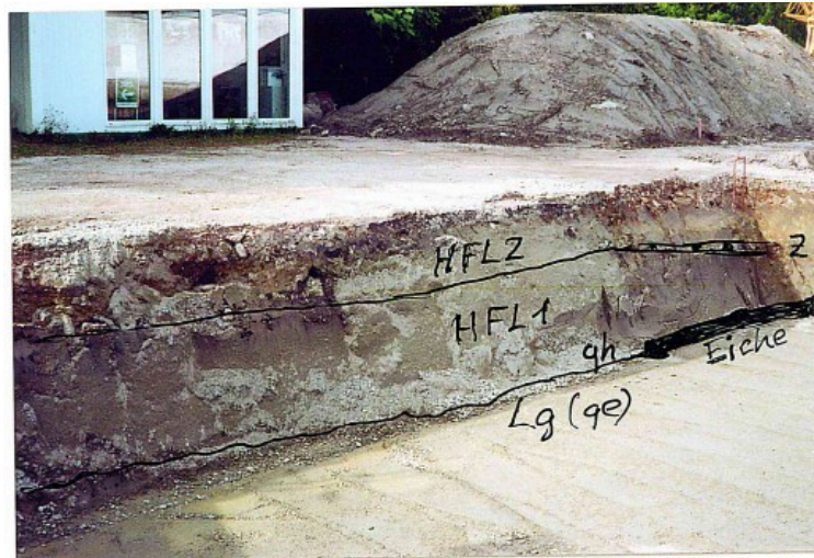
Abb. 3: Blick in die Baugrube Jahnstraße 7, Achern, mit der holozänen Auenlehmdecken (HFL 2 und HFL 1), der Lage der Holzkohleschicht mit Zwetschgen-Kernen (= Z, Profil-mittig rechts) und der Eichenstämme (Holozän-Basis, qh), erosionsdiskordant lagernd auf elsterzeitlicher Grundmoräne, Lg/qe (Foto: Prof. Dr. D. ORTLAM, Bremen).
