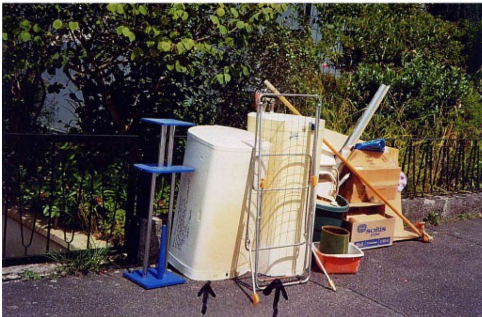
Abb. 1: Zwei total verkalkte Warmwasser-Boiler (Pfeile: 801 +1001; 2006) aus und vor dem Hause Goethestr. 34, 77855 Achern, zum Austausch nach nur 6 bzw. 8 Jahren Nutzungszeit (Instandsetzungskosten: 2.800.--€) – bedingt durch die sehr hohen Gesamthärte-Gehalte im Acherner Trinkwasser (vor 2008).
