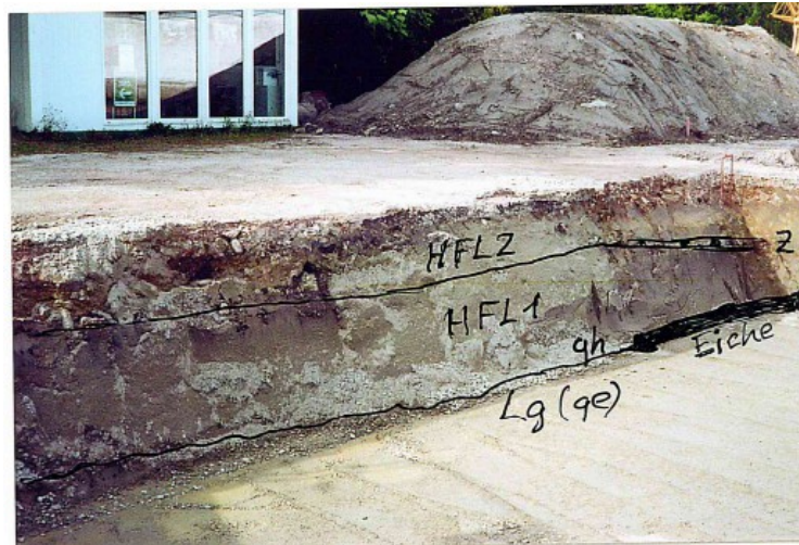
Abb. 3: Blick in die Baugrube Jahnstraße 7, Achern, mit der holozänen Auenlehmdecken (HFL 2 und HFL 1), der Lage der Holzkohleschicht mit Zwetschgen-Kernen (= Z, Profil-mittig HFL2/1, rechts) und der Eichenstämme (Holozän-Basis, qh), erosionsdiskordant auf (umgelagerter) elsterzeitlicher Grundmoräne, Lg/qe (Foto: Prof. Dr. D. ORTLAM, Bremen).
