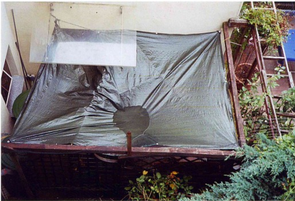
Abb. 16: Dach-Konstruktion (= rezente graue Plastik-Plane) mit zentralem Auffangtrichter zur Gewinnung von Regenwasser bei einer örtlichen Gartenbewässerung in Bremen-Neustadt (Deutschland) als praktisches, rezentes Beispiel der maltesischen Fell-Dächer (= Fell-Velarium ) für eine antike Regenwasser-Zisterne in einem Gutshof , statt Tempel-Anlage (Foto: Prof. Dr. D. ORTLAM 08/2018).
